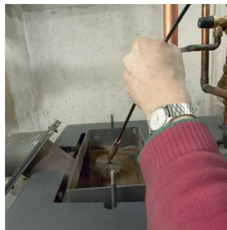
3. Den viska som medföljer vid leverans av Arterm's pellets pannor trycks ner genom rökgaskanalerna så att den sot som fastnat på sidorna faller ned i askbehållarens inre fack.
