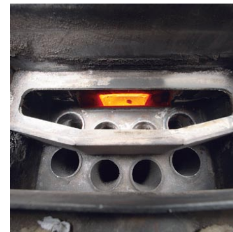
2. Rengöring av rökgaskanalerna. Rökgaskanalerna behöver rengöras (sotas) några gånger per år. De nås genom att sotluckan på pannans ovansida öppnas.
