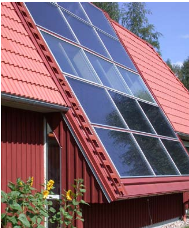
Svesols nya hus värms först och främst av solfångare. Ett säsongsvärmelager under huset lagrar överskottsvärmen från sommaren vilken hämtas upp igen under höst och vinter. När lagret börjar tryta toppar vi med värme från pelletspanna och vattenmantlad pelletskamin.
